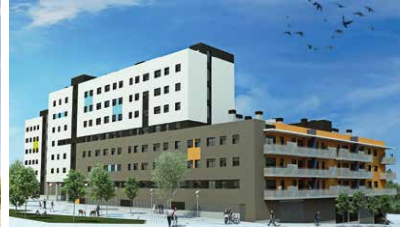
EDIFICI BADALONA STADIUM - BADALONA
